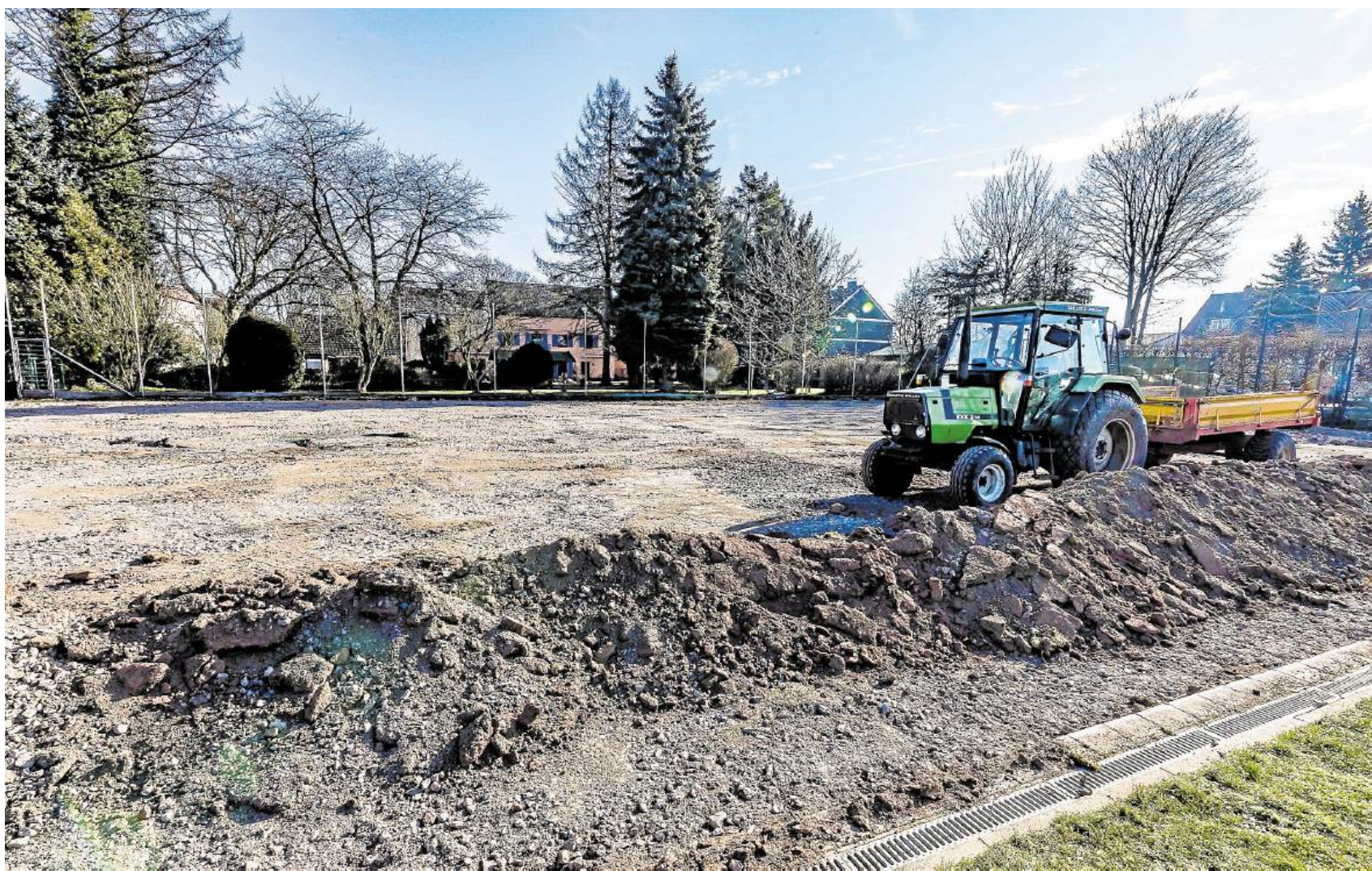
Seit Montag walzen Bagger über den Platz des Allgemeinen Turnvereins in Dorstfeld. Mitte April soll hier ein Kunstrasenplatz sein. RN-FOTO BARZ
